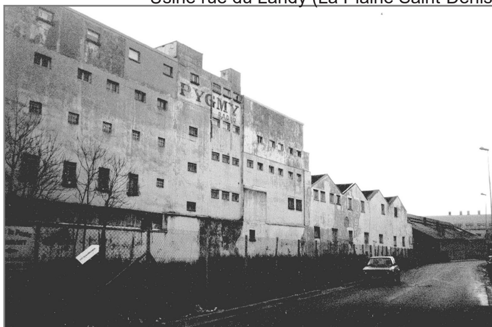
Usine rue du Landy (La Plaine Saint-Denis)
